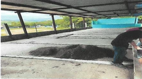
Foto1: Trabajando la sustitución de la torta de concreto 0.08 cms
