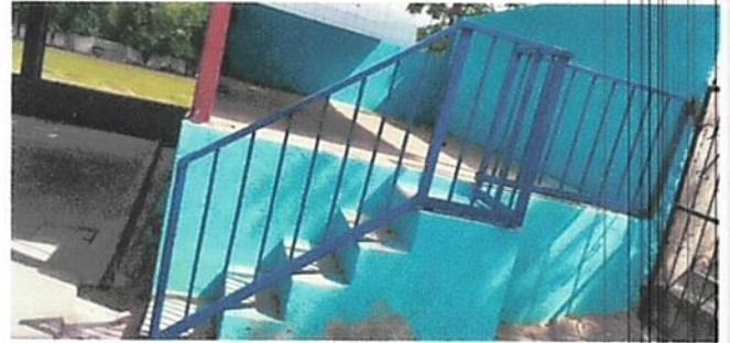
Foto 2: Colocación de baranda de seguridad del escenario.
