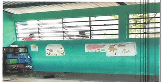
Foto 4: En el cambio de vidrios quebrados.
