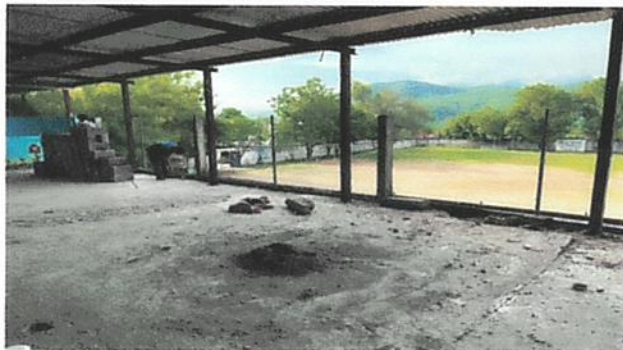
Foto 3: En la construcción de malla cambio.
