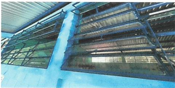
Foto 5: Trabajando la sustitucion de lamina troquelada Alvzin.
